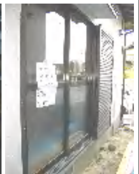
エコガラス(複層の断熱ガラス)に取り替えたところ
