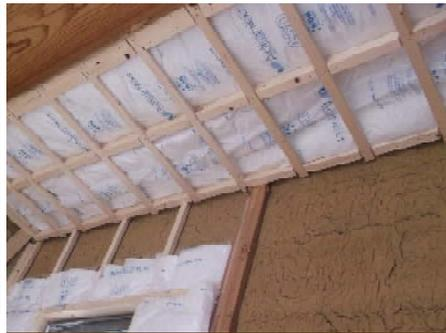
断熱材を 天井・床と窓を入れ替える部分の外壁面へ入れました。サッシも遮熱高断熱仕様へ替えたので 部屋が暖かくなったと喜ばれています。
