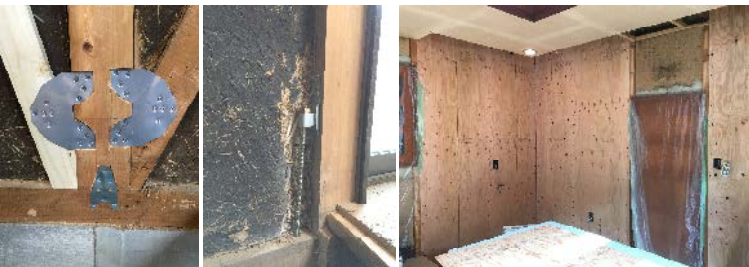
（左写真）耐力壁を造るために「筋違」を設け、柱や梁に「筋違プレート」でしっかりと固定します。（上写真）「ホールダウン金物」で柱と梁、土台を固定。（右写真）構造用合板を張り、壁を補強します。
