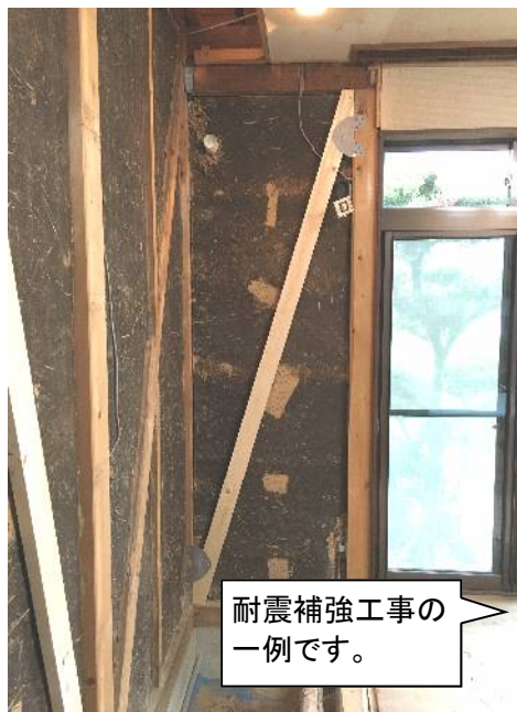
（左写真）耐力壁を造るために「筋違」を設け、柱や梁に「筋違プレート」でしっかりと固定します。（上写真）「ホールダウン金物」で柱と梁、土台を固定。（右写真）構造用合板を張り、壁を補強します。
