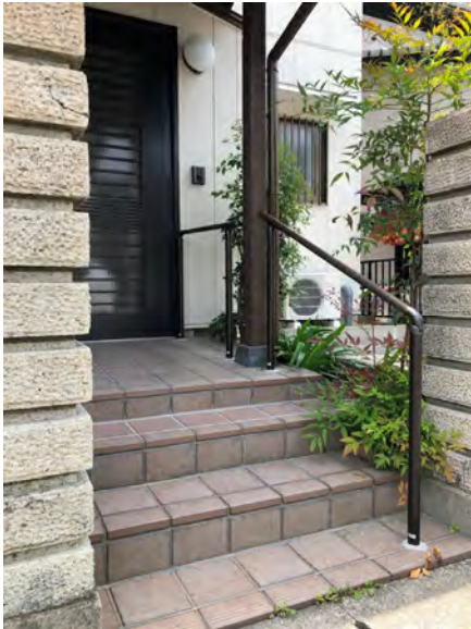
↑ 玄関ポーチと階段
